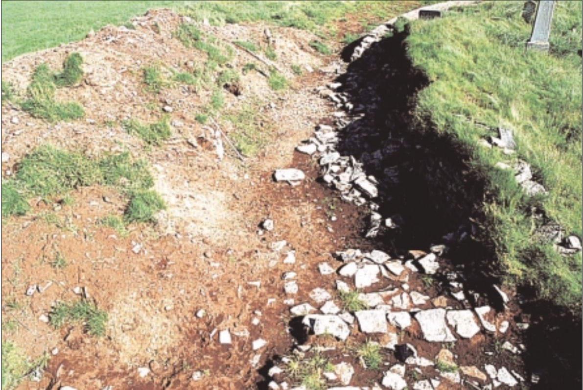
Mynd 5. Fremst má sjá hluta Mannvirkis A en til hægri hallast stika upp að hleðslu á móti kirkjugarðinum. Fjær sést nýhlaðinn garður en nær grjótdreif úr gamla kirkjugarðinum.
